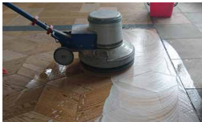
► Abb3. Abreiben mittels Poliermaschine
