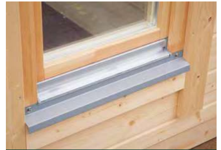
Fenster mit Metall-Fensterbank
