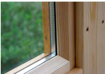
Isolierverglaste Leimholz-Fenster
