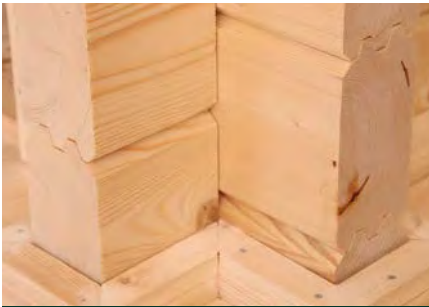
Eckverbindung 70-mm-Bohle
