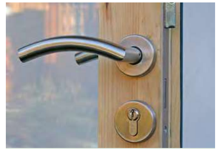
Edelstahl-Türbeschlag und Zylinderschloss
