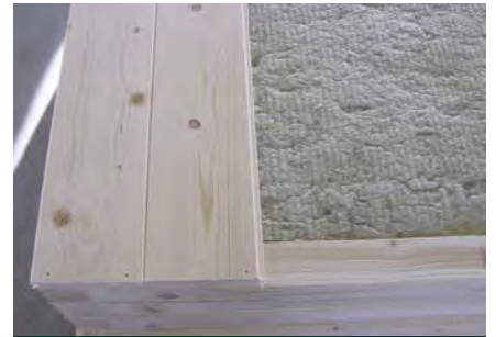
Gedämmte Zwischendecke im Saunaraum
