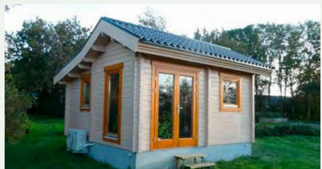
Sondermodell 92 mm Wandstärke
