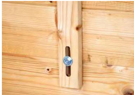
Sturmleiste bei Wandstärken 28 und 40 mm
