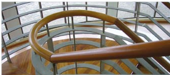
Gefräste Rundhandläufe horizontal gebogen
