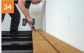
Die Verschraubung der Dielen auf den mittleren Schienen erfolgt nach dem Prinzip der ersten Reihe: anzeichnen, vorbohren und verschrauben.
