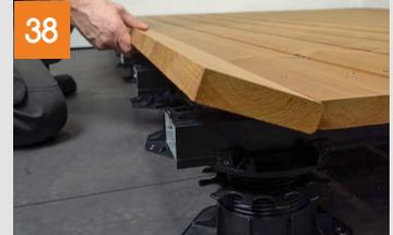
Zur Fixierung der letzten Diele wird Terrafix in der Mitte durchgebrochen und die Hälften an den Enden der Schienen aufgelegt.
