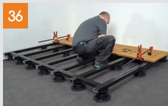
Die nächsten Dielen in der Fläche werden nach dem zuvor beschriebenen Prinzip verlegt. Dabei erleichtern die Spannzwingen die Montage der Dielen und sorgen für einen maßgenauen Fugenabstand.
