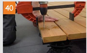
Mit der Bohrmarkierschablone werden die Bohrpunkte angezeichnet und anschließend vorgebohrt.
