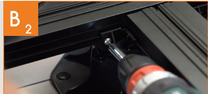
Unterkonstruktion ausrichten und mit Lagern verschrauben
