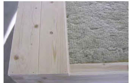
Gedämmte Zwischendecke im Saunaraum
