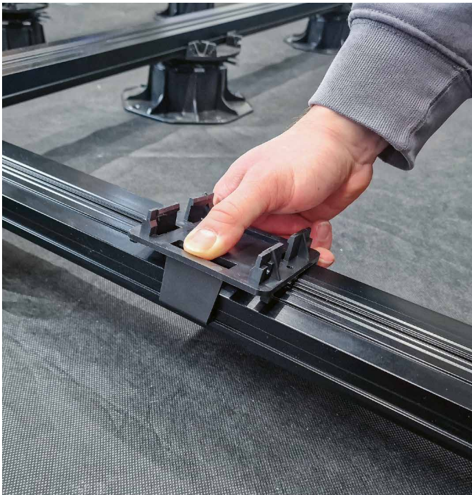
KL-Kreuzverbinder auf die ausgerichtete Konterlattung einklicken
