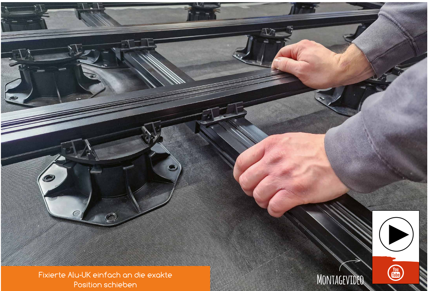
KL-Kreuzverbinder auf die ausgerichtete Konterlattung einklicken
