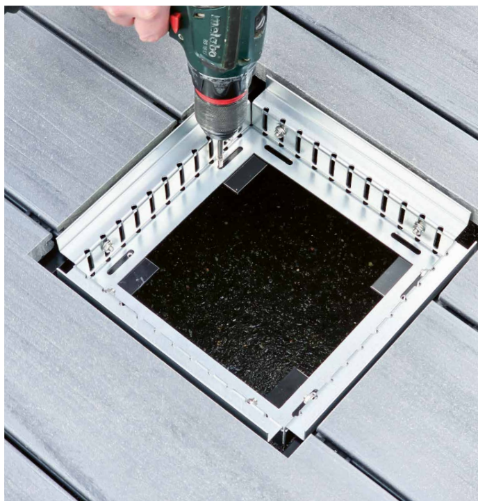
Revisionskasten einsetzen und an Windlastträger verschrauben
